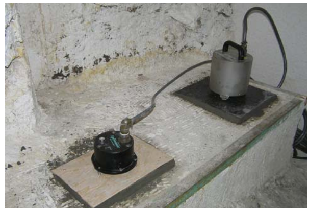
Episensorul ES-T și sensorul seismic BB CMG-40TD de la stația seismică Soroca
