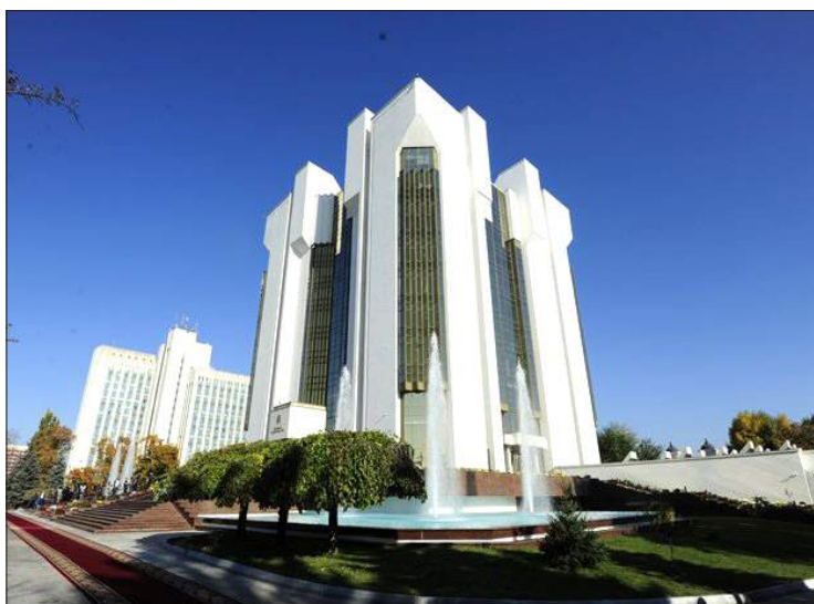
Figura 2. Palatul Președintelui Republicii Moldova după reparație ( http://www.moldova.md/ro/content/cladirea-presedintiei-fost-inaugurata-dupa-renovare ).
