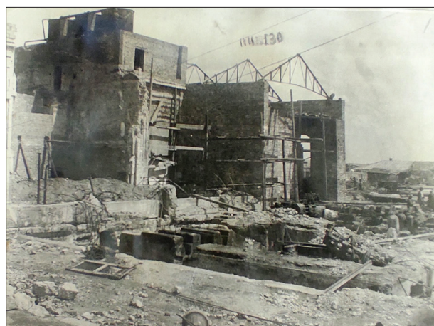
Figura 6. Uzina Electrică din Chișinău minată și aruncată în aer de către sovietici, vara anului 1941 [36, f. 1].
